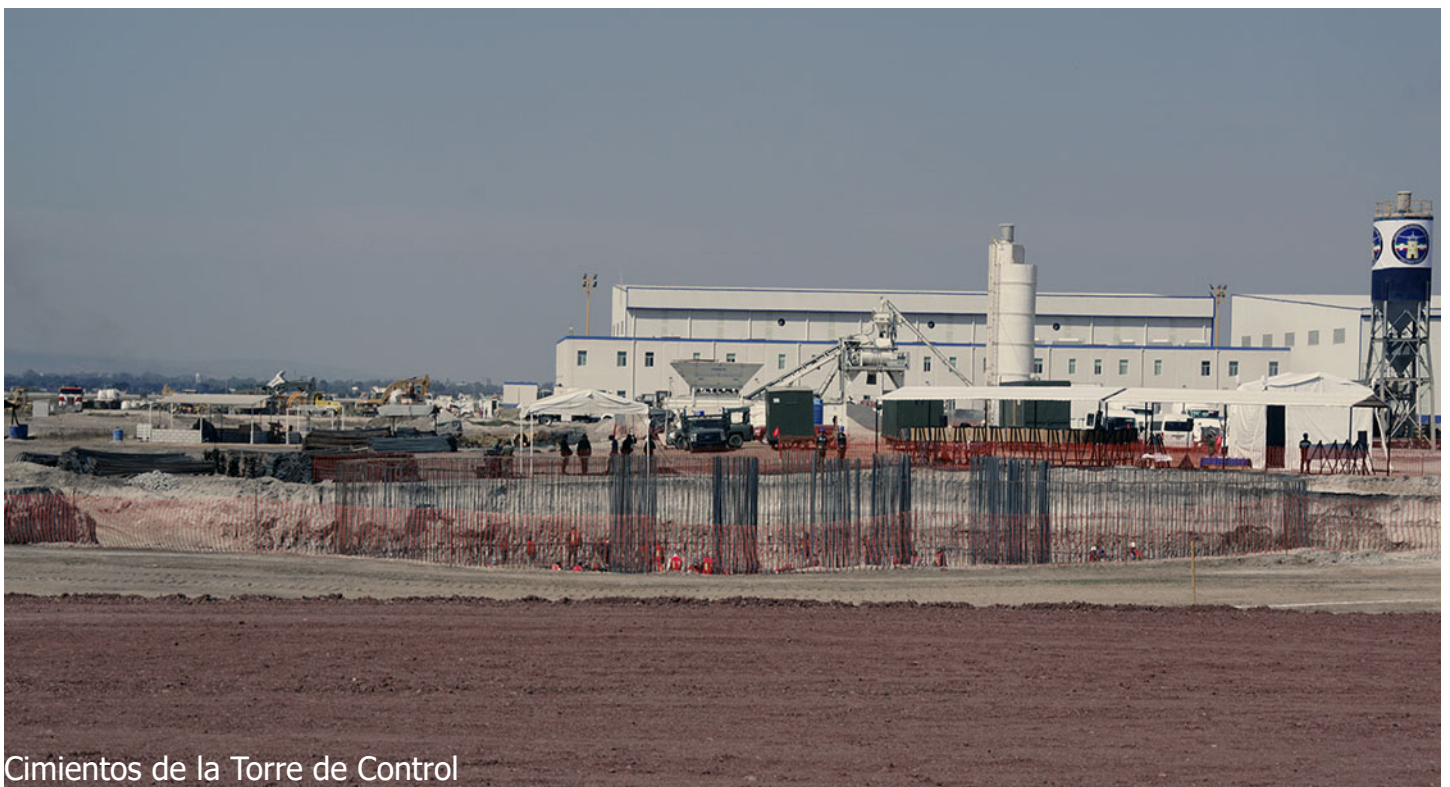
Decenas de maquinas trabajan en la construcción
