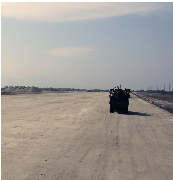
Pista Central excavada y aplanada www.espacioaereo.net | Noviembre 2019
